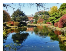
旧東京医学校本館
